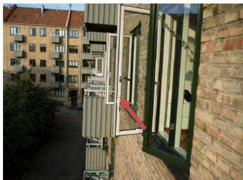
Foto 2: Tætningslister på rammer
